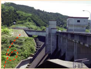
この部分がロックフィル (石積み)部分です
